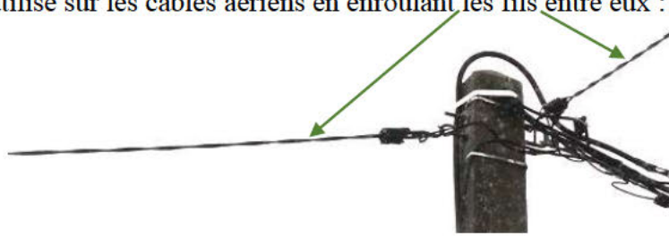
Pièce A.44 - Exemple de fils électriques torsadés sur le réseau électrique basse tension (photographie)
